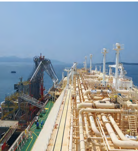
LNG 재액화 설비 개조
