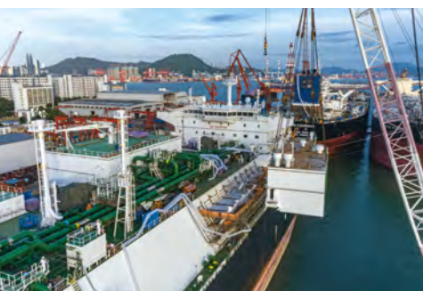
LNG 재액화 설비 개조
